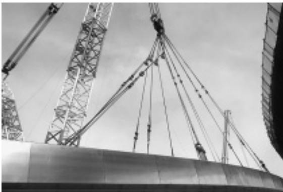
写真-3 イコライザー方式を用いた吊具
