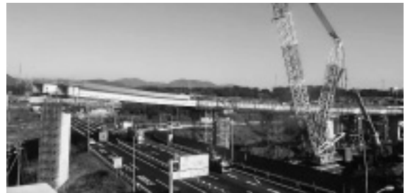
写真-4 架設完了
