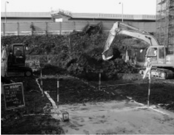
写真-2 攪拌機混合工法施工状況
