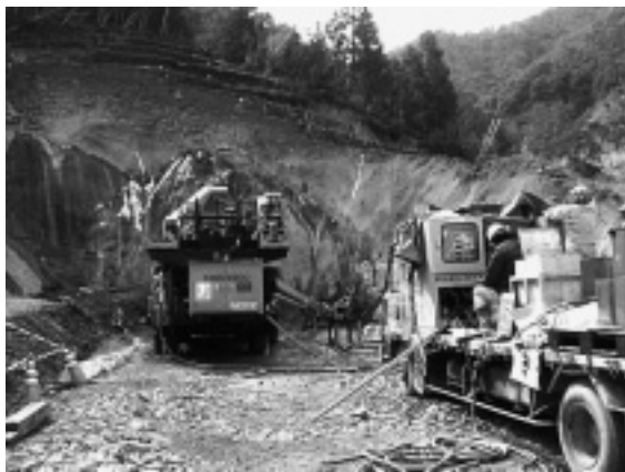
写真-1 AGF 坑外施工
