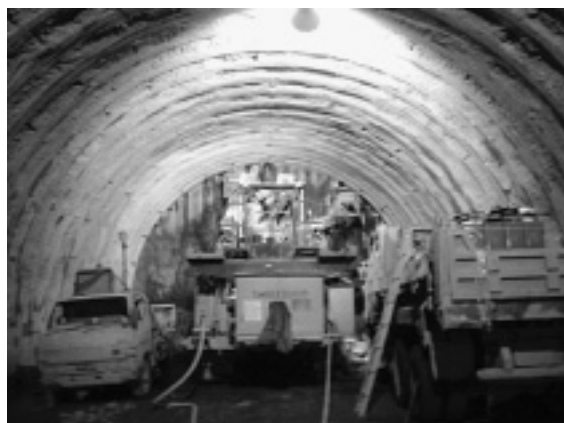
写真-2 AGF 坑内施工
