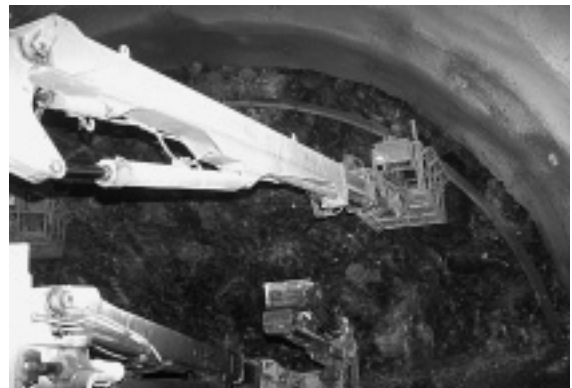
写真-3 施工状況写真（建て込み）
