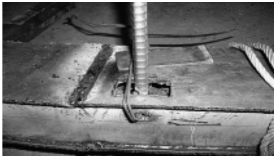
写真-1 鋼製支保工定規
