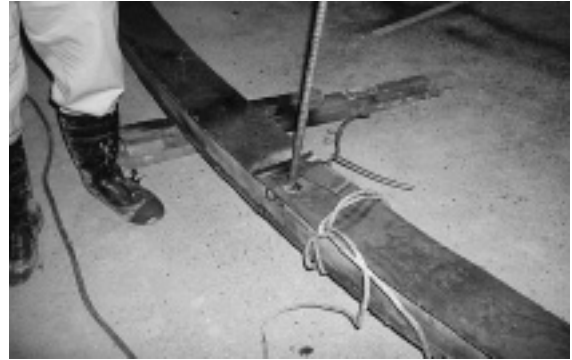
写真-2 鋼製支保工定規
