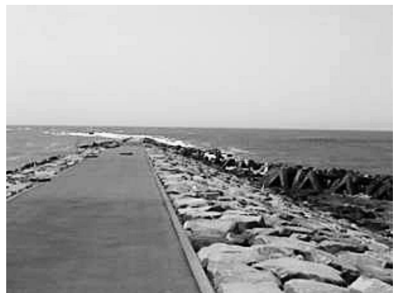
写真-2 施工場所
