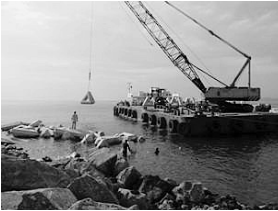
写真-3 据付状況
