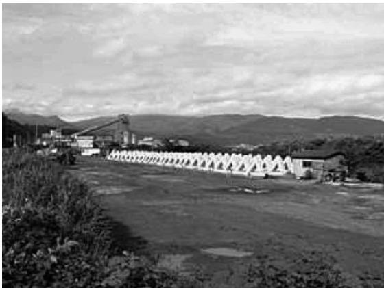
写真-4 制作ヤード
