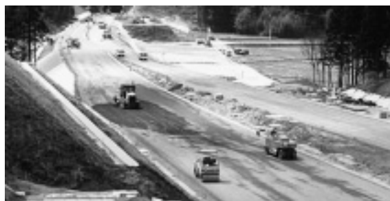
写真-2 上層路盤施工状況
