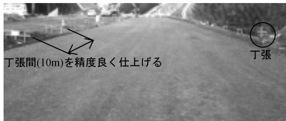
写真-1 丁張間の仕上げ
