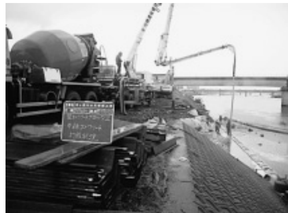
写真-5 中詰コンクリート打設状況
