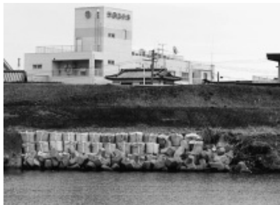
写真-1 全景（対岸から）
