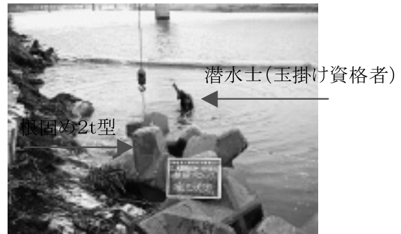
写真-4 撤去状況
