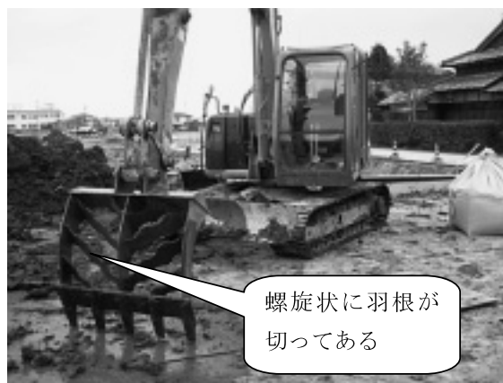
写真-4 攪拌バケット
