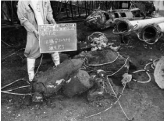
写真-7 橋台コンクリート撤去完了
