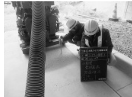
写真-2 骨材露出確認状況
