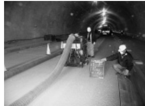
写真-1 ショットブラスト施工状況
