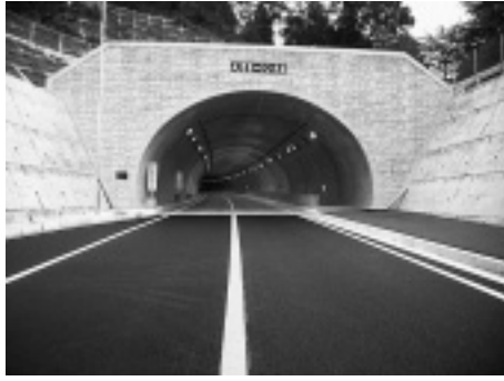
写真-5 完成写真（東京側坑口から撮影）
