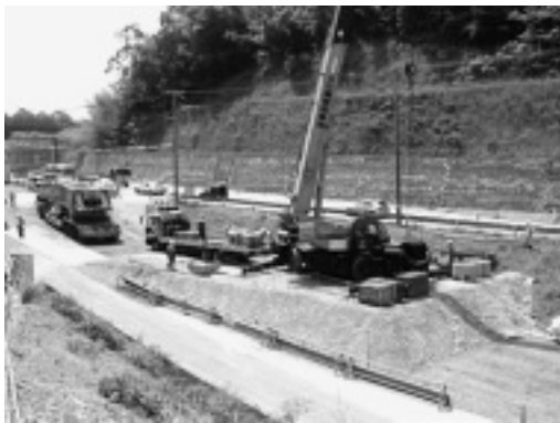
写真-2 盛土状況
