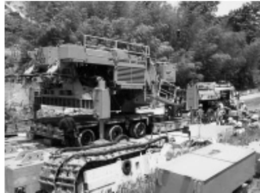
写真-3 荷卸し状況
