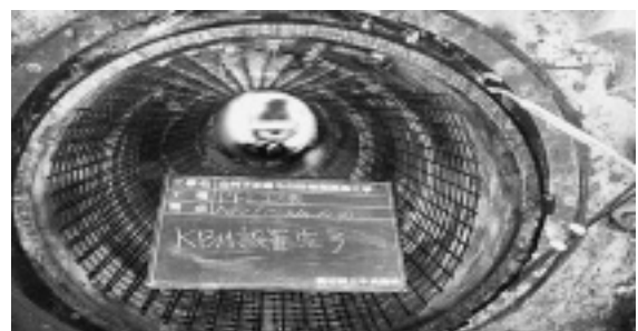
写真-3 KBM 設置工
