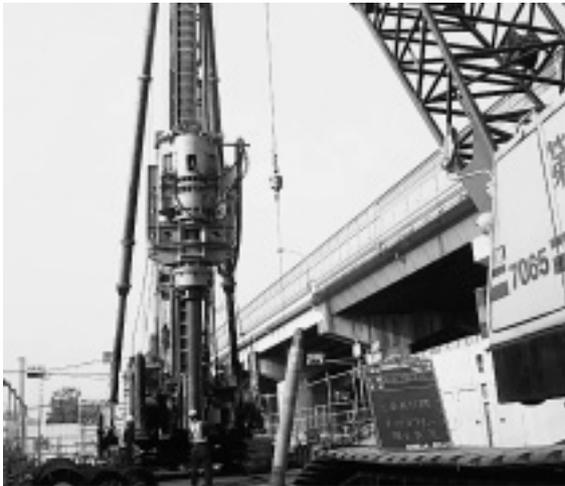
写真-4 鋼管中掘杭
