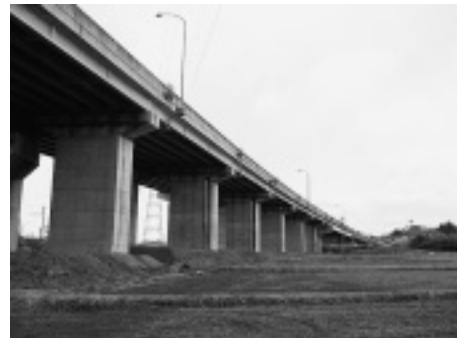
写真-1 耐震補強完了全景
