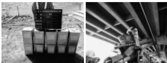
写真-2 膨張材と現場での投入状況
