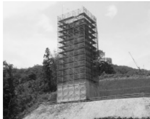
写真-5 橋脚躯体施工状況
