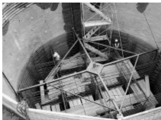
写真-2 専用吊金具による設置状況
