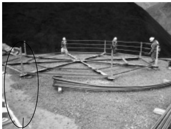
写真-1 ガイドへの仮組状況
