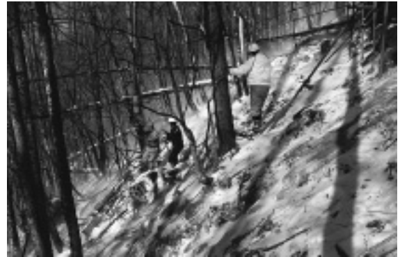
写真-4 吊荷場玉掛班作業状況
