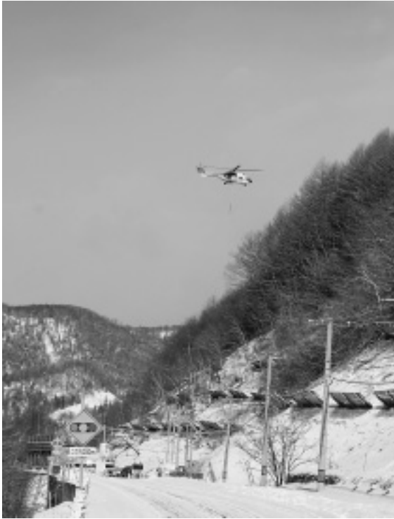
写真-5 現場上空での荷吊り状況
