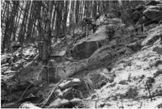
写真-3 人力小割り（予備ネット防護）
