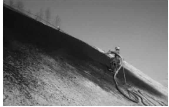
写真-9 吹付け施工状況
