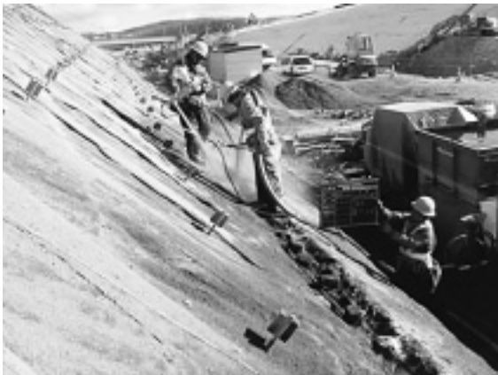
写真-5 連続繊維補強土工施工
