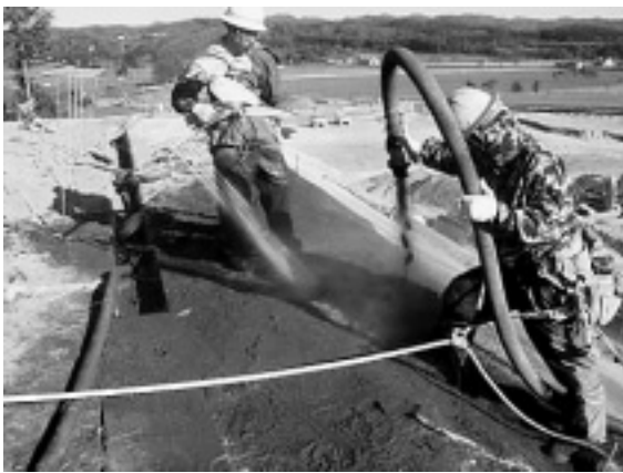
写真-4 連続繊維補強土工施工
