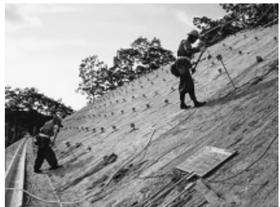
写真-2 アンカー鉄筋挿入
