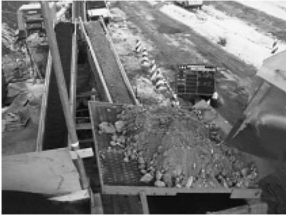
写真-3 現地発生砂の混合
