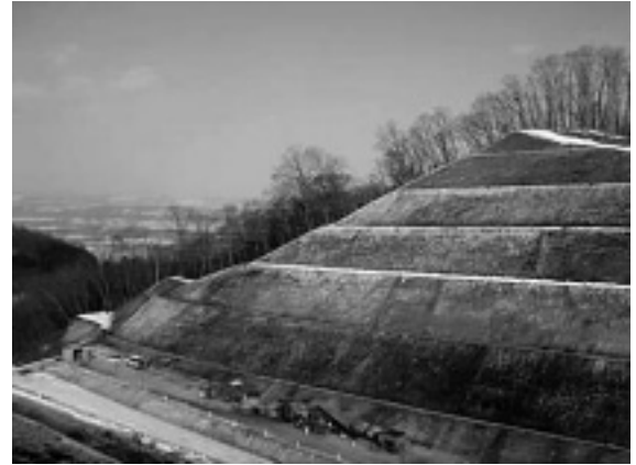
写真-6 施工完了全景
