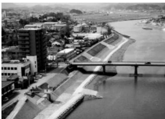
写真-9 施工完了後
