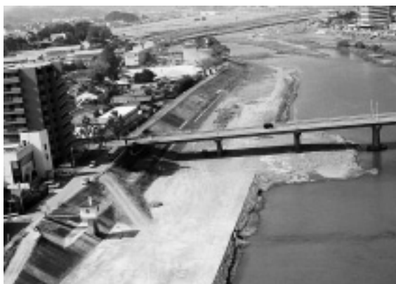
写真-8 着手前状況
