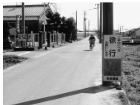
写真-5 規制区間看板設置
