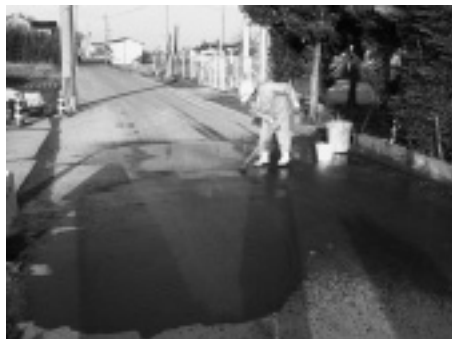
写真-9 一般車道清掃状況
