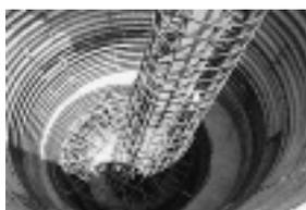
写真-5 配筋完了
