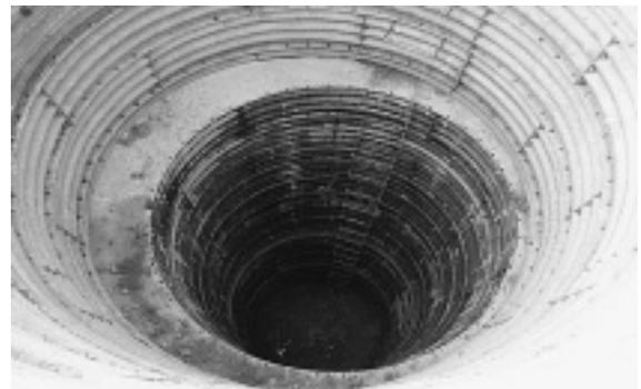
写真-2 坑内（鉄塔基礎工事分）
