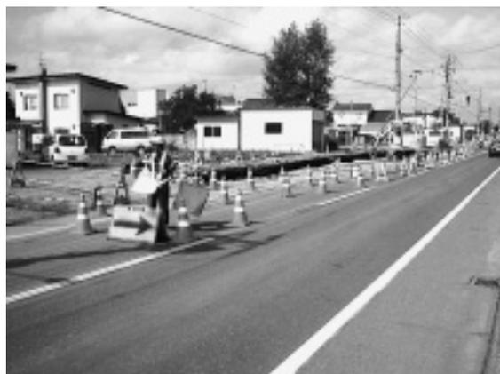
写真-3 片側規制状況
