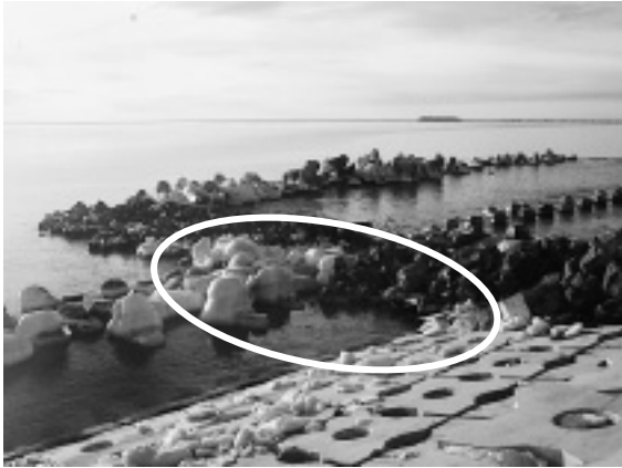
写真-5 中割石投入による両袖の波除工
