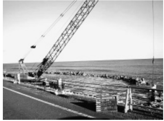
写真-7 波除工据付状況
