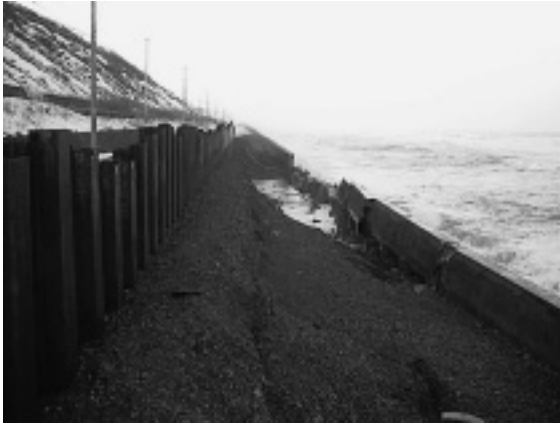
写真-1 地震・高波による被災状況
