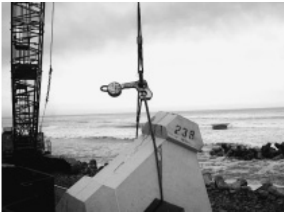
写真-6 自動解除装置
