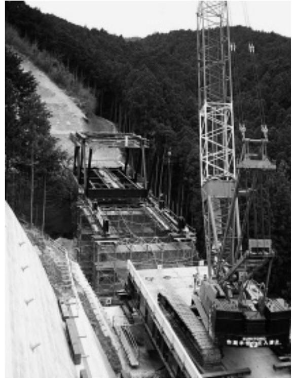
写真-1 P2-P3間下弦材架設
