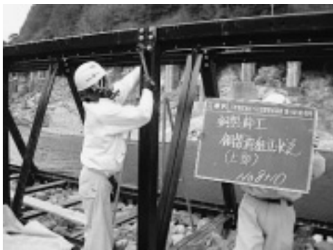
写真-3 鋼製枠組立
