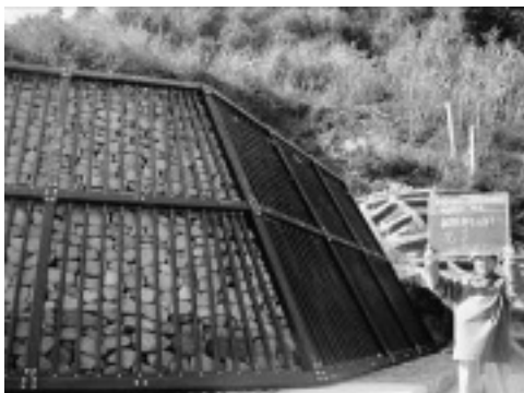
写真-4 鋼製枠完了
