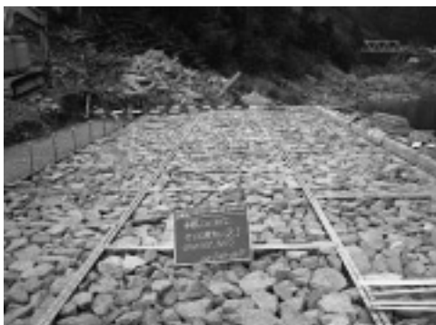
写真-5 鋼製フトン籠設置
