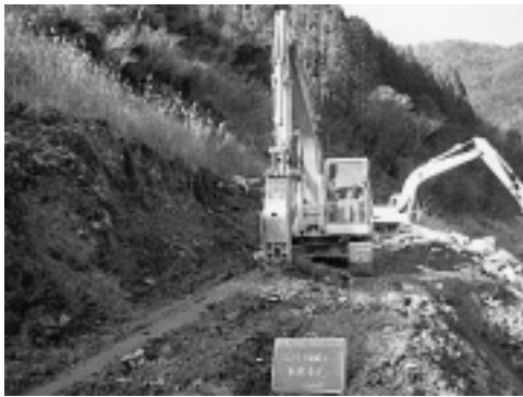
写真-2 コンクリート取壊し
