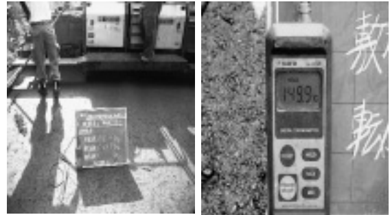
写真-3 敷均温度状況
