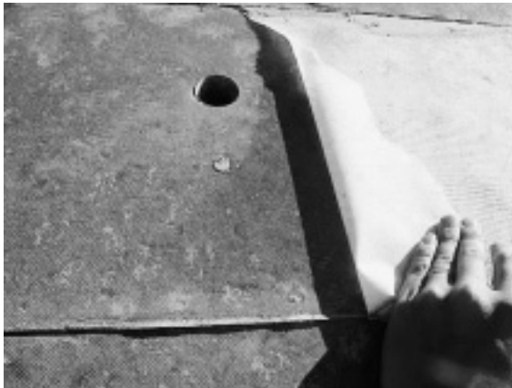
写真-5 コンクリート表面
