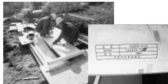
写真-4 型枠表面へフィルターシートを貼り付け(500円/m 2 )
