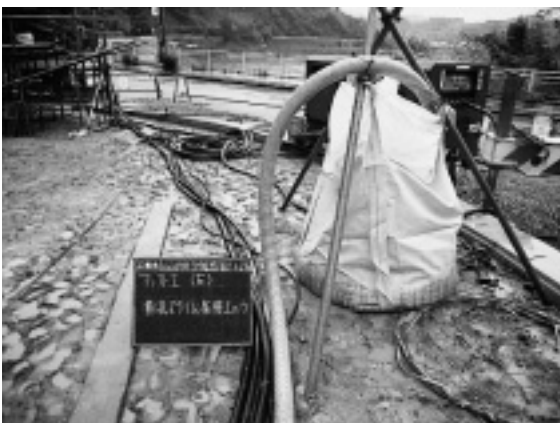
写真-7 スライム処理状況
