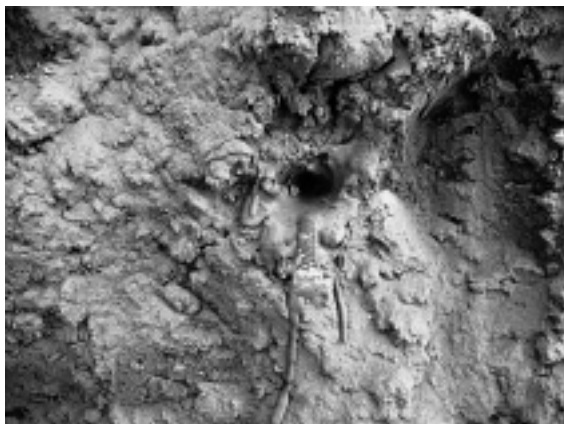
写真-2 引き抜き防止にセメントミルクを流し込む
