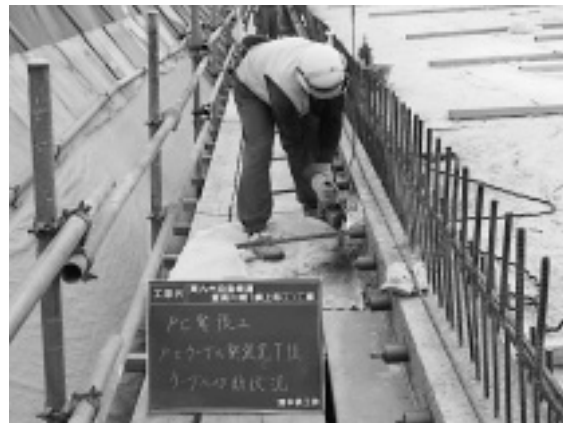
写真-7 緊張端側の PC 鋼線切断状況
