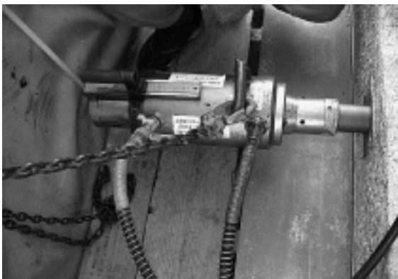
写真-5 PC鋼線緊張状況
