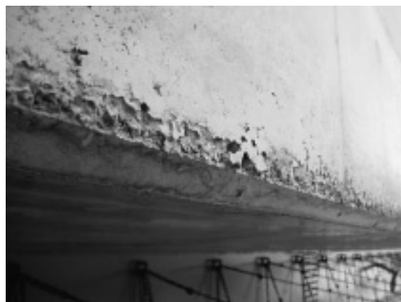
写真-9 壁高欄水切り部のジャンカ
