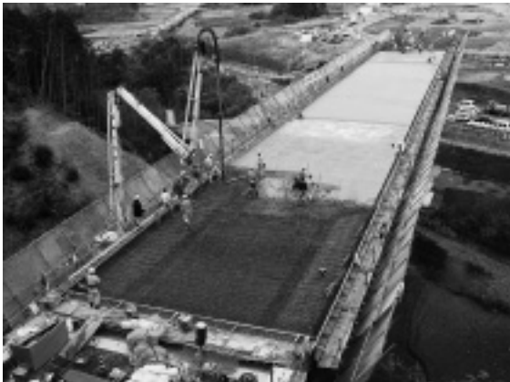
写真-1 床版打設状況
