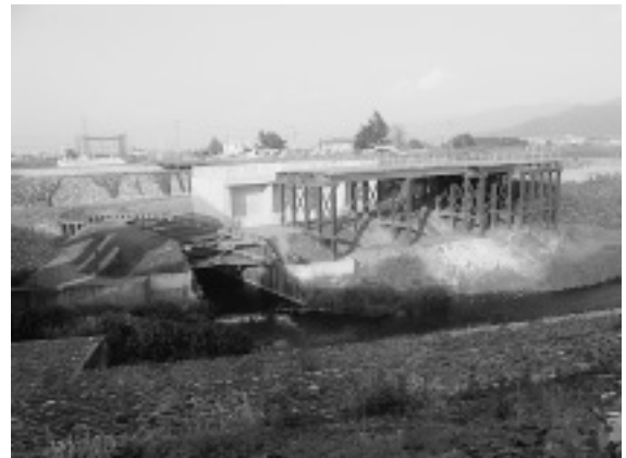
写真-8 完成（下流より上流を望む）
