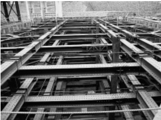
写真-2 切梁・腹起し設置完了 (5段)
