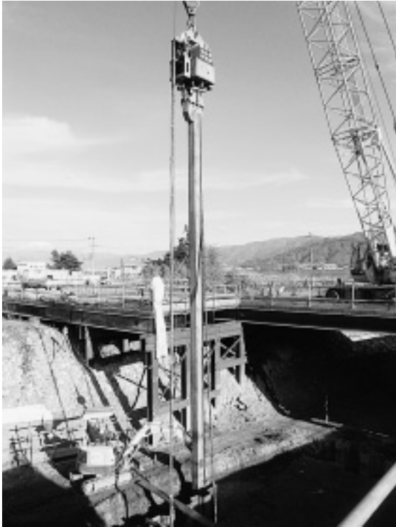
写真-1 鋼矢板打込み (L=22.5m)
