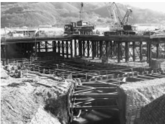
写真-3 掘削土積込状況
