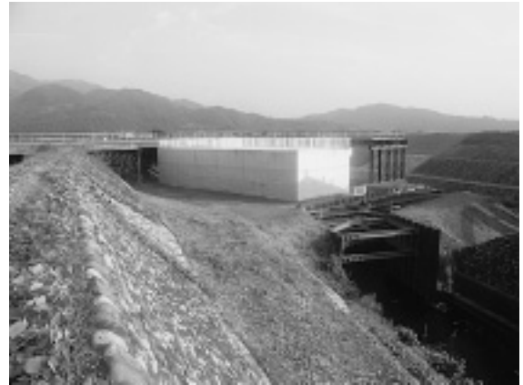
写真-7 完成（上流より下流を望む）
