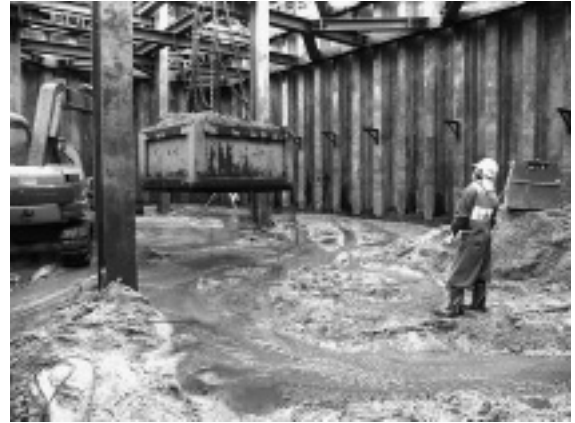
写真-4 立孔内掘削状況
