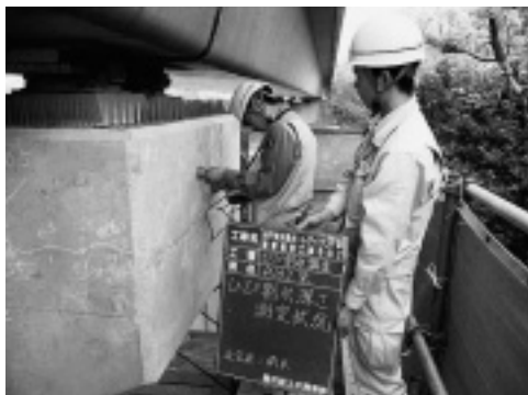
写真-3 ひび割れ深さ調査状況
