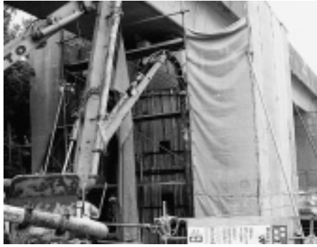
写真-9 柱部へのコンクリート打設状況
