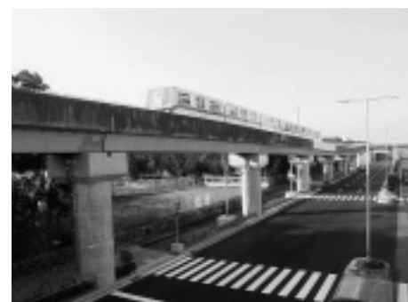
写真-12 施工完了
