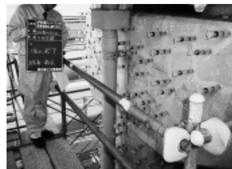
写真-7 柱部へのひび割れ注入状況 1
