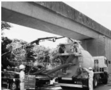
写真-11 梁部への打込み状況
