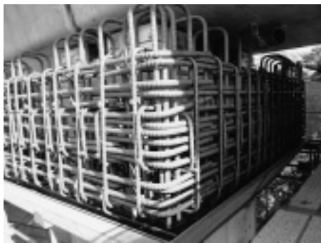
写真-10 梁部の配筋状態
