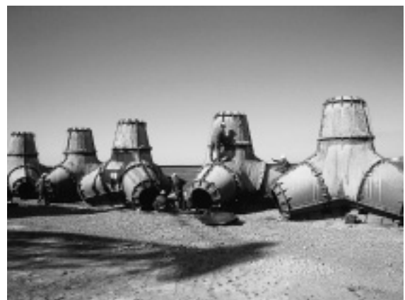
写真-2 型枠組立状況
