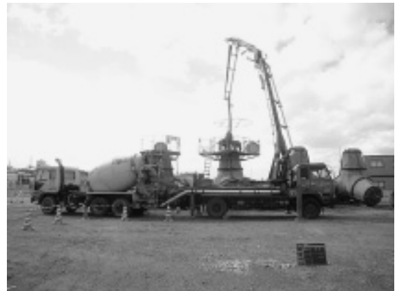
写真-4 コンクリート打設状況 (全景)
