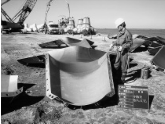
写真-3 剥離剤塗布状況
