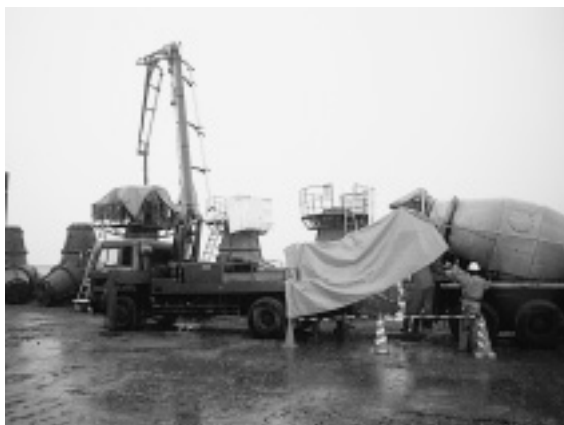
写真-6 降雨時コンクリート打設状況
