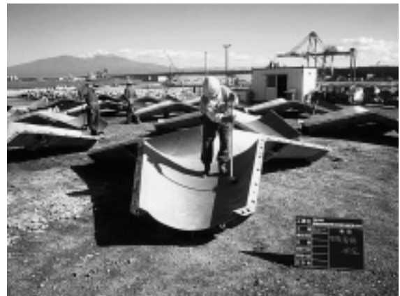
写真-1 型枠清掃状況
