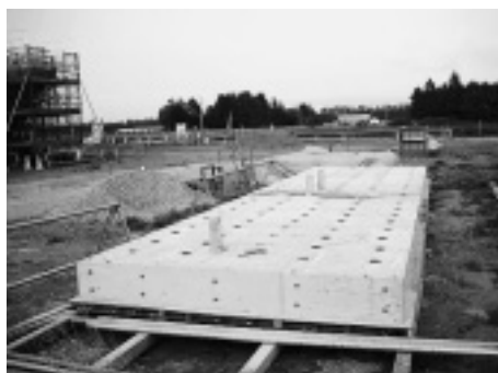
写真-5 試験施工型枠脱型後
