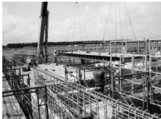
写真-1 架設状況
