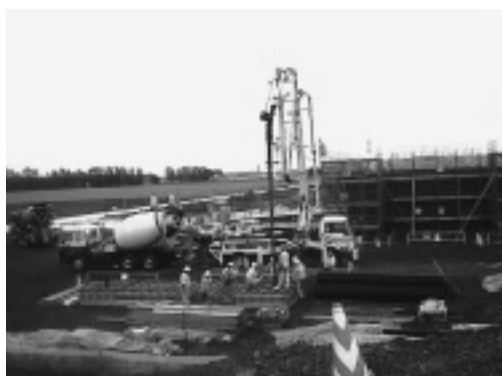
写真-3 打設状況
