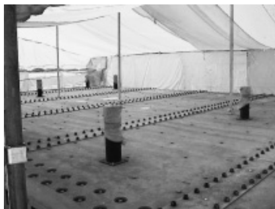
写真-2 架設完了
