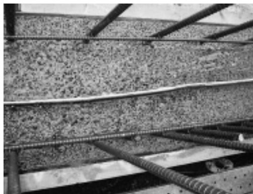
写真-1 打継目レイトランス処理
