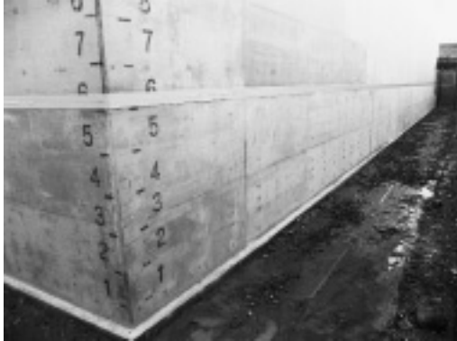
写真-2 ポリウレタン系樹脂による防水処理
