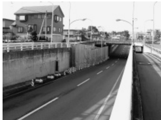
写真-2 仮設足場設置完了
