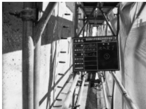
写真-3 ひび割れ注入完了
