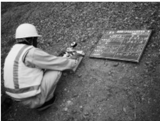
写真-7 施工後試験片付着強度試験
