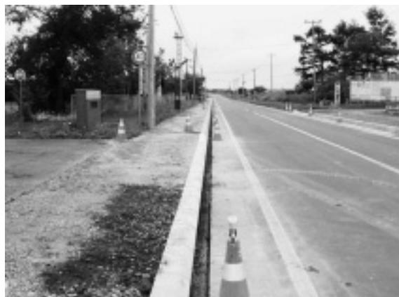
写真-3 アスファルト安定処理完了
