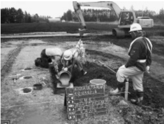
写真-5 試験施工状況 T=45cm
