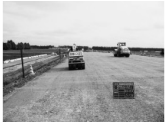
写真-6 転圧状況
