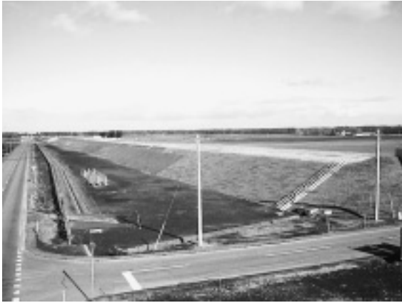
写真-1 完成写真
