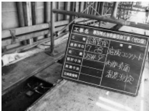
写真-7 内部・表面温度測定
