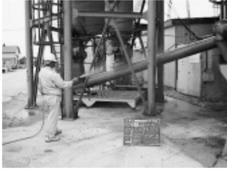
写真-2 セメントタンク散水冷却
