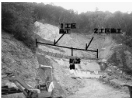
写真-4 防護柵の設置
