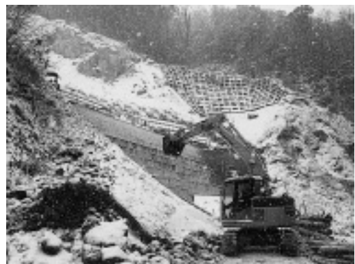
写真-1 冬期の施工
