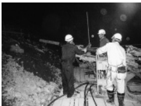
写真-5 ボーリングマシンの稼働
