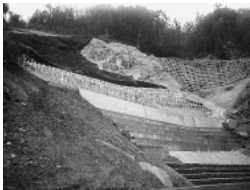
写真-6 完成全景
