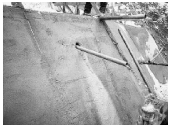
写真-3 水抜孔を増設
