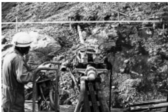
写真-2 ボーリング暗渠工の掘削
