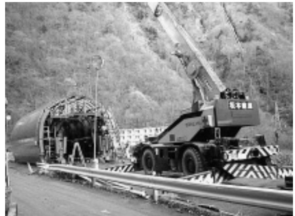
写真-1 スライドセントル組立状況
