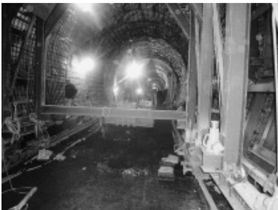
写真-6 バラセントル移動状況
