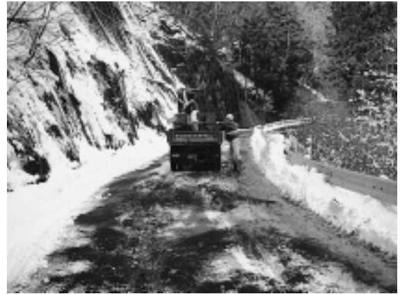
写真-4 砂散布状況
