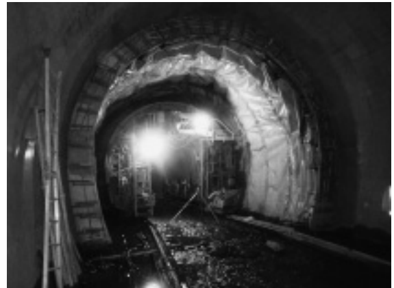
写真-7 面壁型枠施工状況
