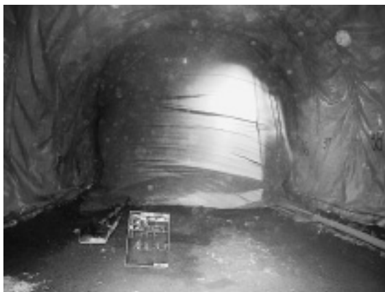
写真-3 セントル被覆シート
