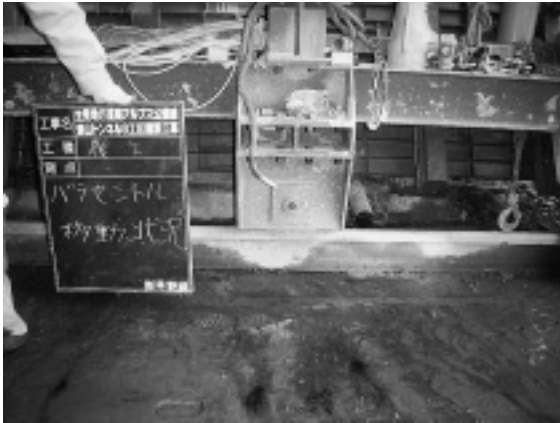
写真-5 バラセントル車輪設置状況
