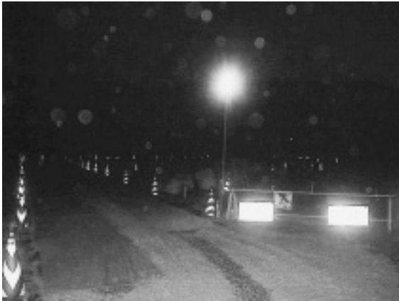
写真-4 迂回路工 安全施設設置状況
