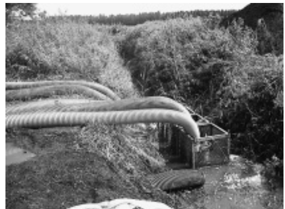
写真-6 水中ポンプ設置状況
