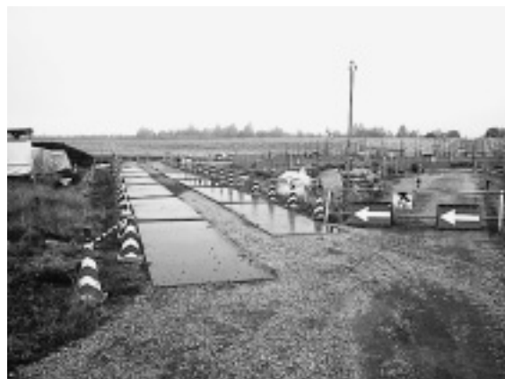
写真-3 迂回路工敷鉄板敷設状況
