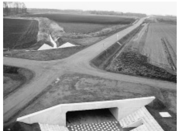
写真-1 完成写真
