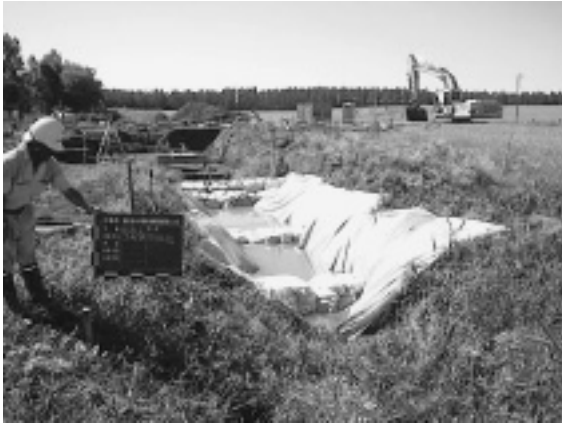
写真-8 沈砂池設置状況
