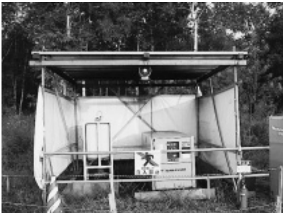
写真-9 屋根囲い状況
