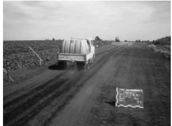
写真-10 散水状況
