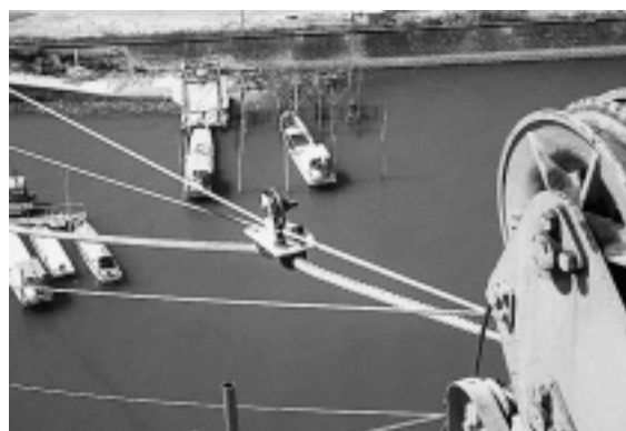
写真-4 トラックケーブル展開状況
