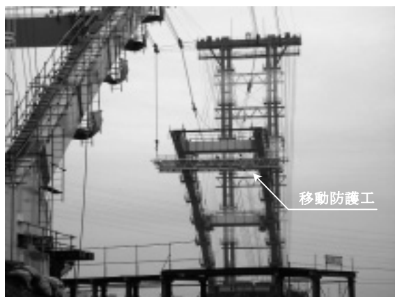
写真-3 上支材架設状況
