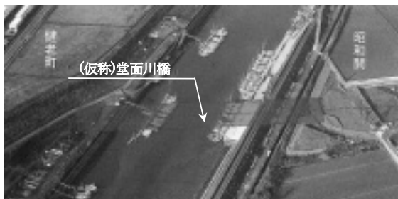
写真-1 架設位置
