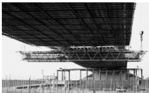
写真-2 移動防護工
