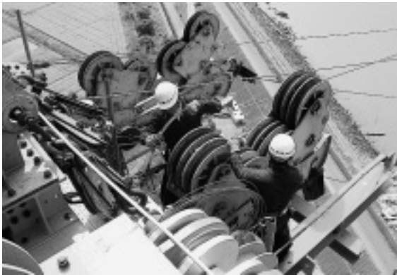
写真-6 ワイヤ繰り込み状況
