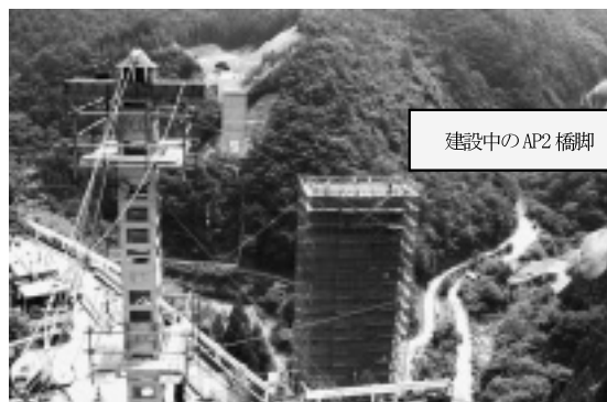
写真-3 2.9t吊ケーブルクレーン
