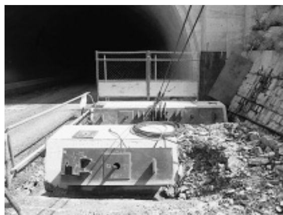
写真-4 A1ケーブルクレーンアンカー
