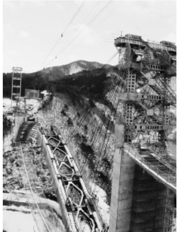
写真-1 厳冬の斜吊架設（平成18年 2月）
