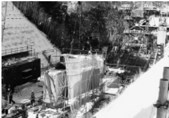
写真-6 ジョイント部養生状況
