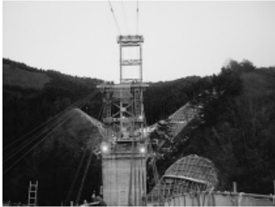
写真-5 斜吊鉄塔・ケーブルクレーン鉄塔の照明設備
