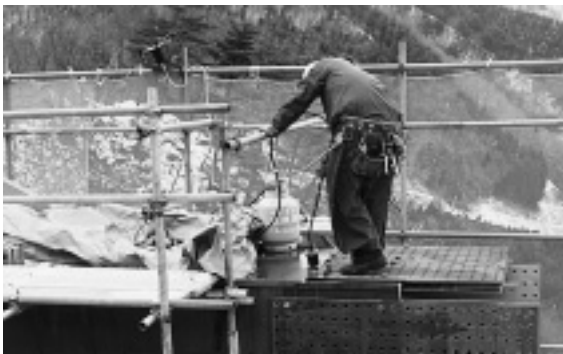
写真-7 ジョイント部乾燥状況
