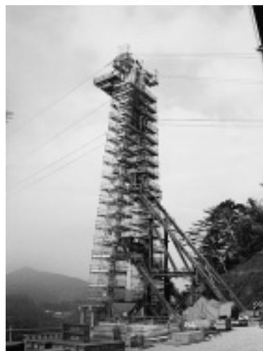
写真-5 P2主塔架設状況
