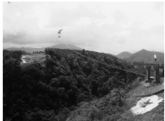
写真-4 パイロットロープ張渡し作業状況
