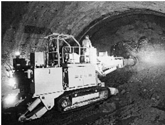
写真-1 機械掘削状況
