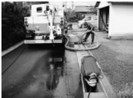
写真-14 側溝の清除
