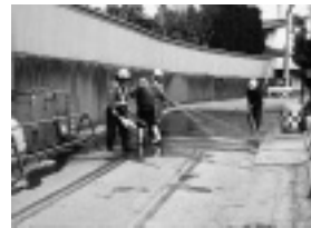
写真-9 道路水洗い、土場に塩カリ撒き・散水
