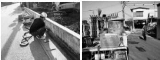
写真-12 カッター切断時の吸収機の使用と汚泥処理機の使用
