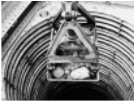
写真-3 立坑掘削
