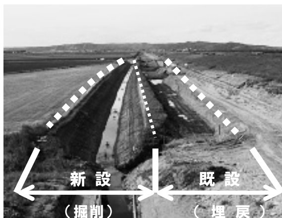
写真-1 施工状況
