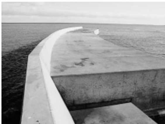
写真-6 完成全景
