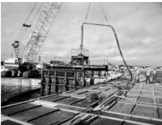
写真-2 背面コン打設
