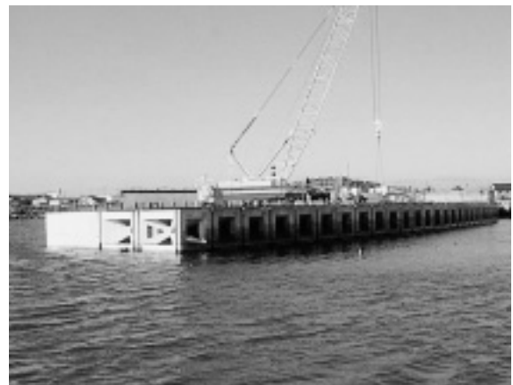
写真-5 面コンクリート完了
