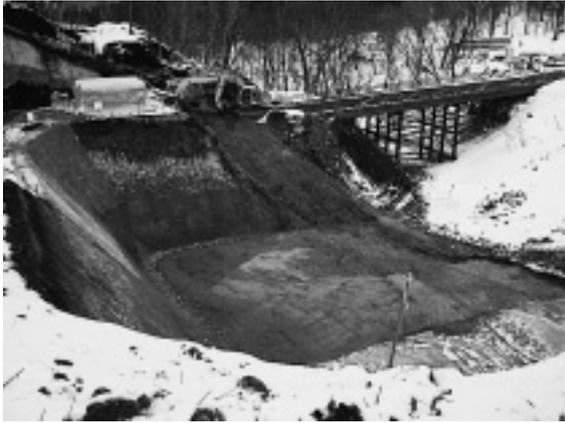
写真-1 深礎杭 施工運搬路
