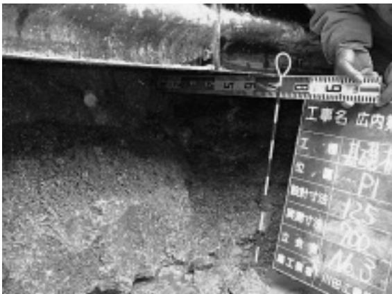
写真-4 ライナープレート背面 空洞状況
