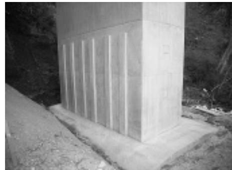
写真-7 橋脚 RC 巻立完了
