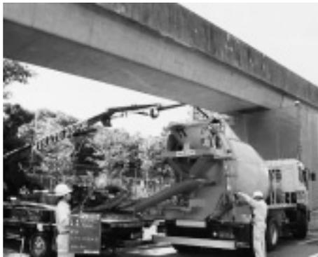
写真-11 梁部への打込み状況
