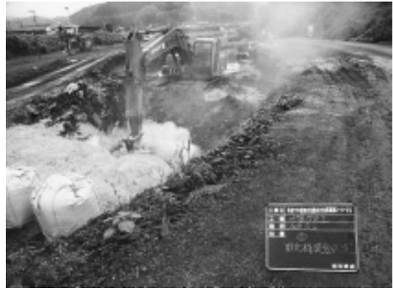
写真-2 固化材攪拌状況
