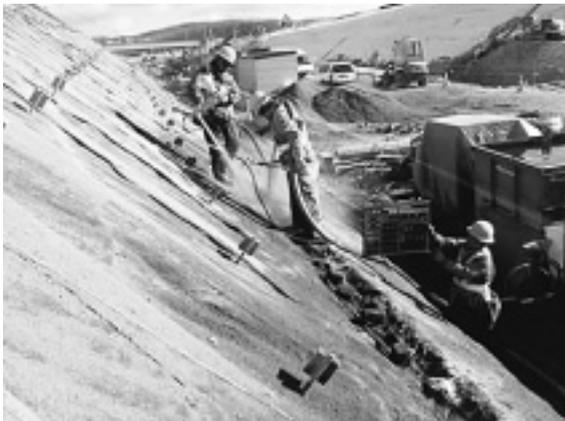
写真-5 連続繊維補強土工施工
