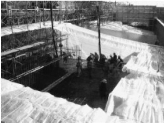
写真-6 仕切りの計画により囲い延長が可能
