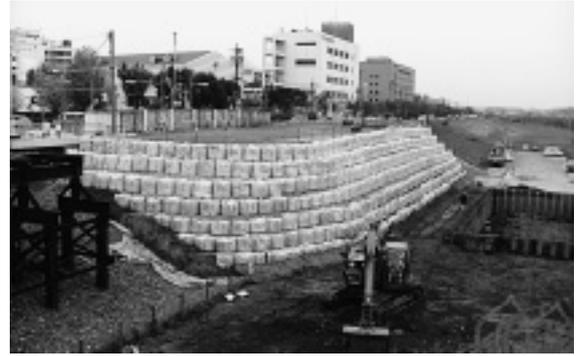
写真-4 大型土のう施工
