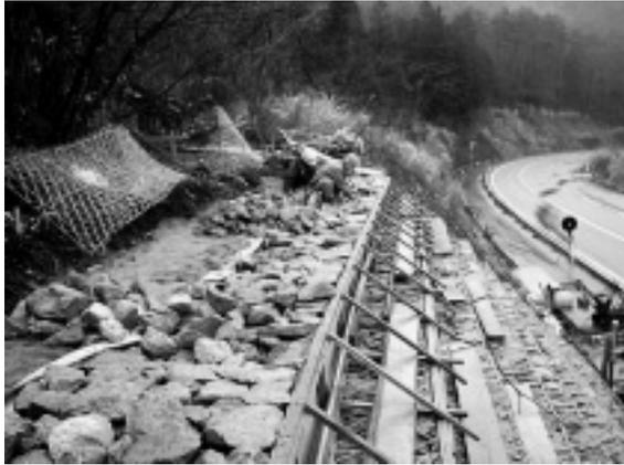
写真-1 合板型枠の使用状況
