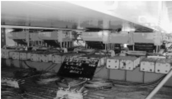
写真-4 シンクロジャッキ設置状況
