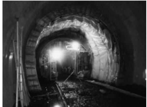
写真-7 面壁型枠施工状況
