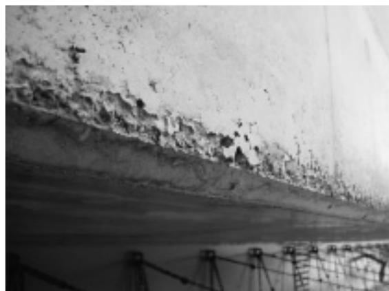
写真-9 壁高欄水切り部のジャンカ
