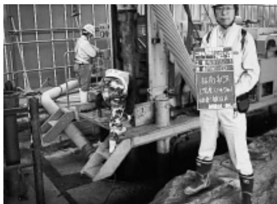
写真-1 低空頭リバース (TBH) 工法
