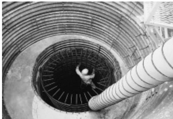
写真-14 ステップ降下（配筋作業時）
