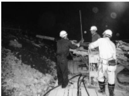
写真-5 ボーリングマシンの稼働
