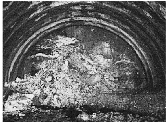
写真-2 発破掘削状況
