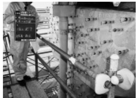
写真-7 柱部へのひび割れ注入状況 1
