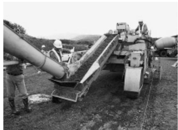
写真-1 コンクリート投入状況
