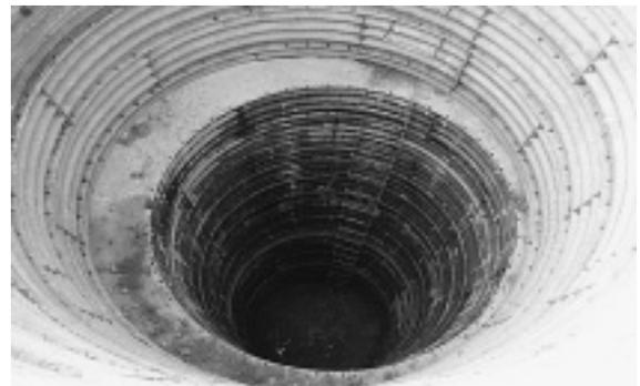
写真-2 坑内（鉄塔基礎工事分）
