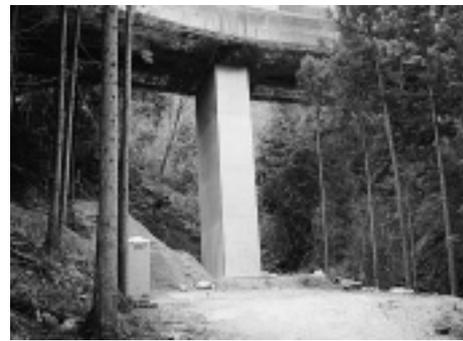
写真-6 橋脚 RC 巻立全景
