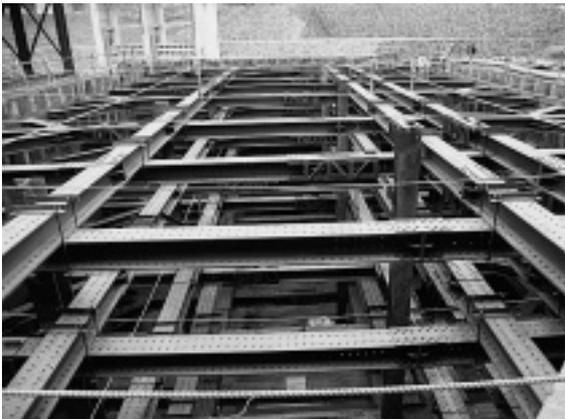
写真-2 切梁・腹起し設置完了 (5段)
