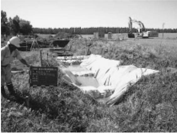
写真-8 沈砂池設置状況
