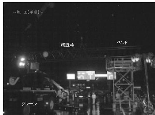
写真-3 施工状況（連結梁設置時）
