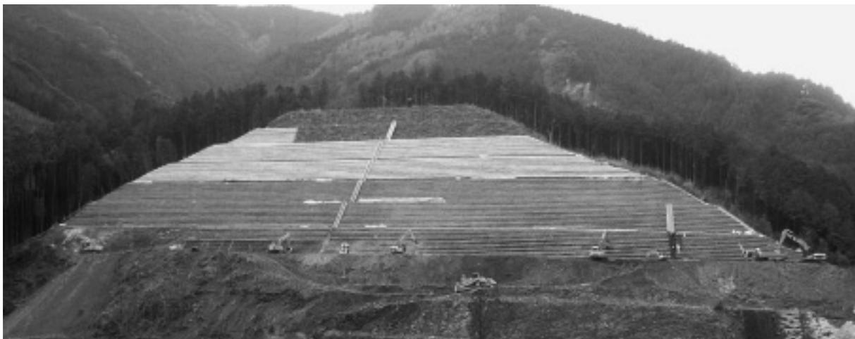
写真-3 法面工（ポット苗）全景
