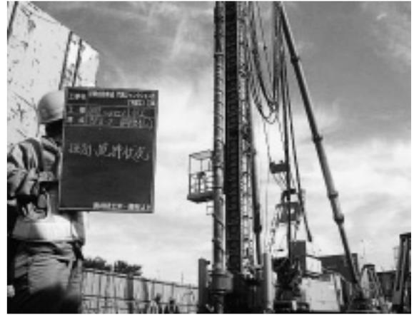
写真-5 鋼管ソイルセメント杭
