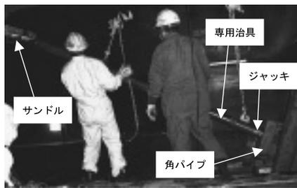
写真-2 腹板の桁矯正状況（箱桁内）
