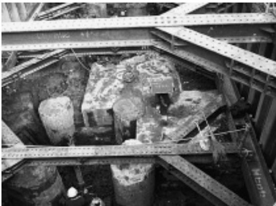
写真-8 静的破碎材挿入孔削孔状況
