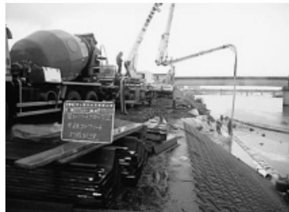
写真-5 中詰コンクリート打設状況
