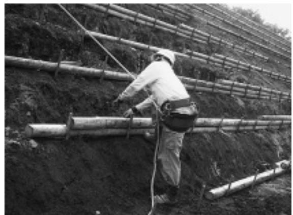
写真-2 間伐材（タイコ切り）設置状況
