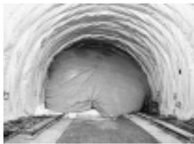
写真-4 シート養生と加熱養生
