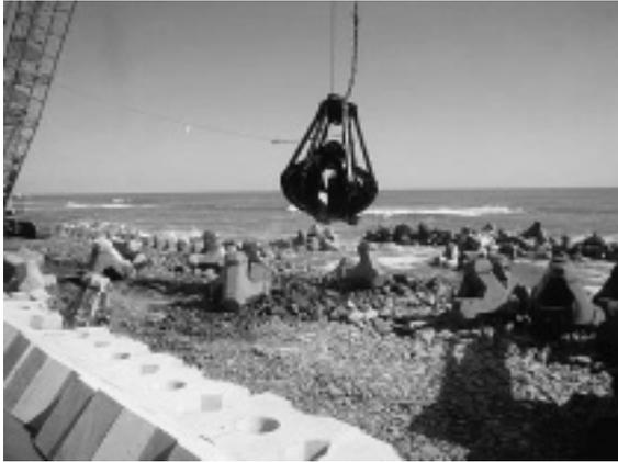
写真-3 オレンジピールバケツ及び回収状況
