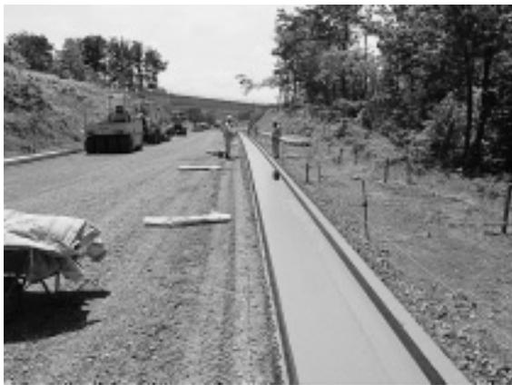
写真-3 コンクリート打設完了
