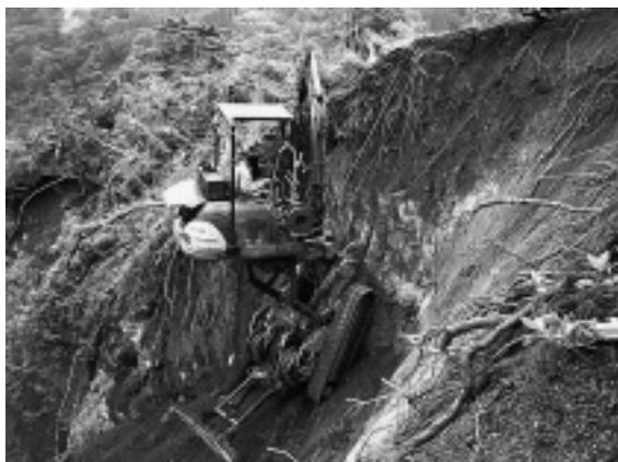
写真-3 急傾斜バックホウ 作業状況
