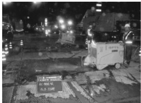
写真-1 舗装版切断状況
