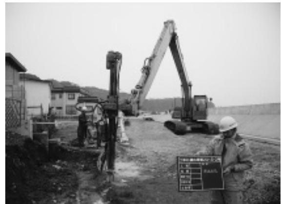
写真-1 重機械取付け式の削岩機
