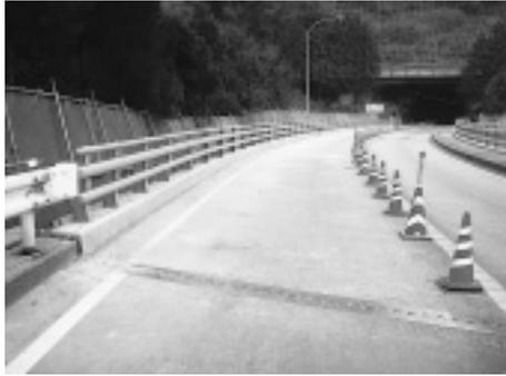
写真-5 橋の高欄兼防護柵取替状況
