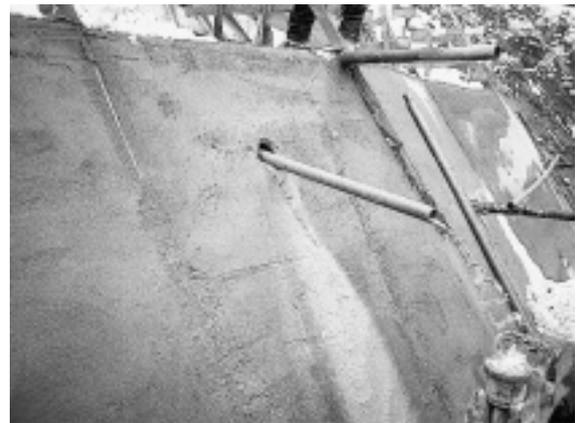
写真-3 水抜孔を増設
