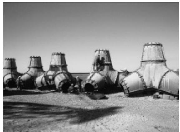
写真-2 型枠組立状況
