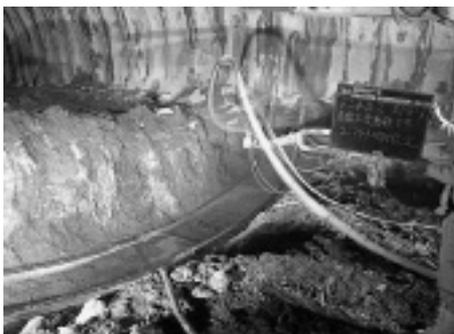
写真-3 鋼製ストラット取付状況
