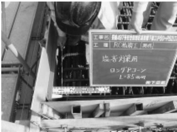
写真-2 L=85mmの長尺Pコーン
