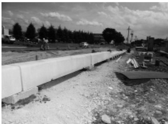
写真-1 歩車道ブロック据付状況
