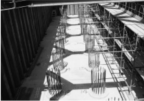
写真-10 杭施工完了
