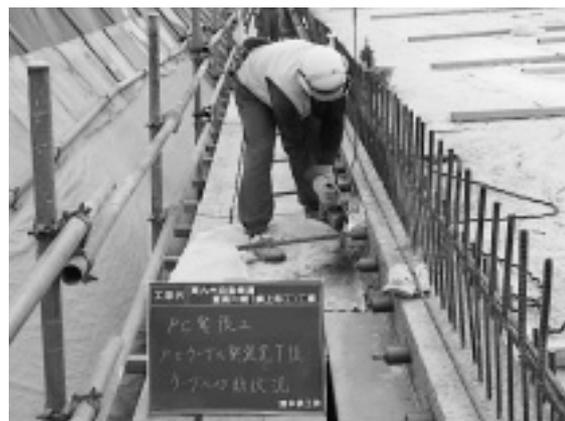
写真-7 緊張端側のPC鋼線切断状況
