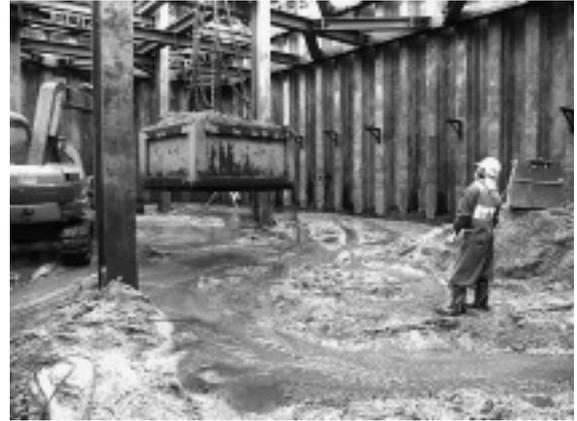
写真-4 立孔内掘削状況
