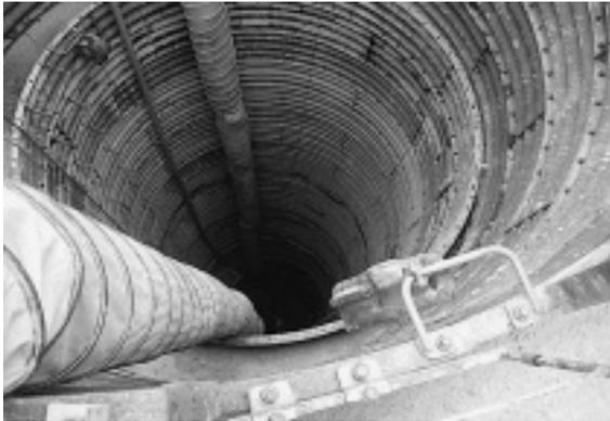
写真-12 コの字金具・安全ブロック設置
