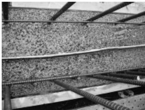
写真-1 打継目レイトランス処理
