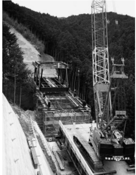
写真-1 P2-P3間下弦材架設
