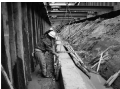
写真-3 型枠脱型状況
