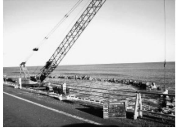
写真-7 波除工据付状況
