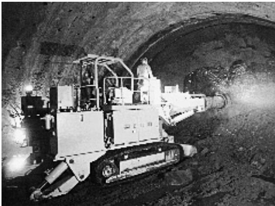
写真-1 機械掘削状況
