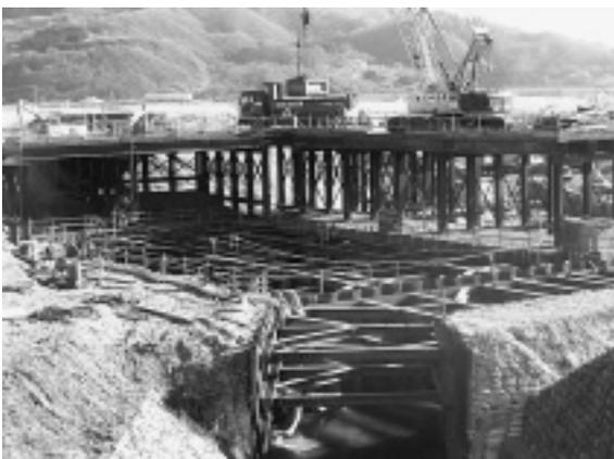
写真-3 掘削土積込状況
