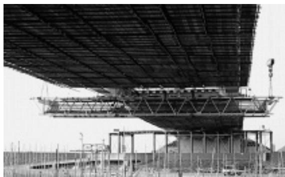
写真-2 移動防護工
