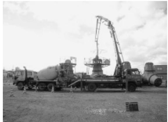
写真-4 コンクリート打設状況 (全景)
