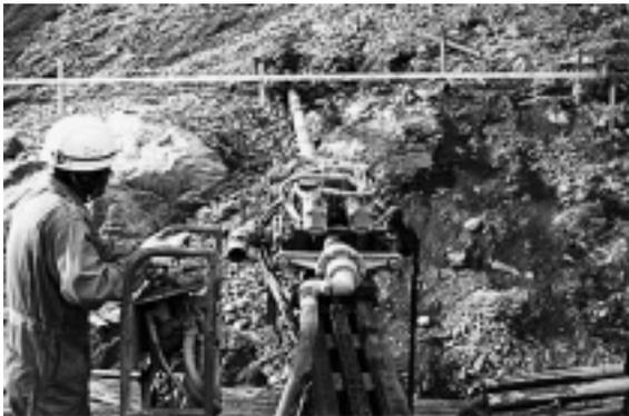
写真-2 ボーリング暗渠工の掘削
