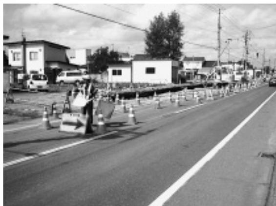
写真-3 片側規制状況
