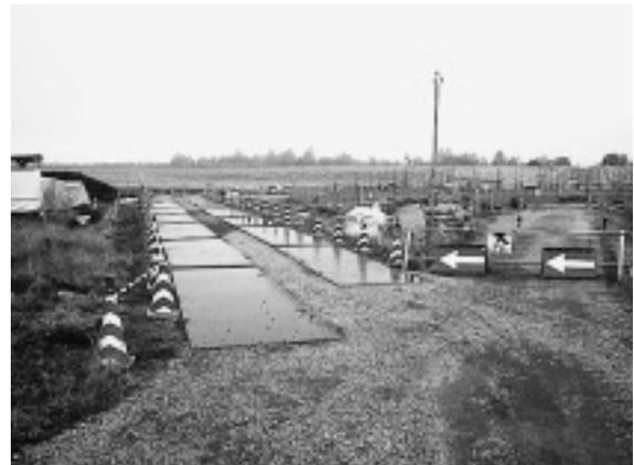
写真-3 迂回路工敷鉄板敷設状況
