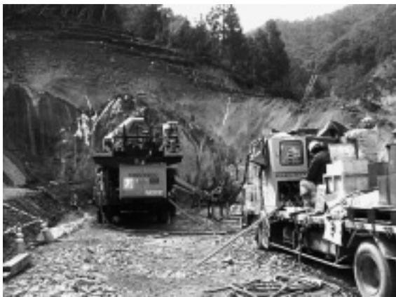
写真-1 AGF 坑外施工
