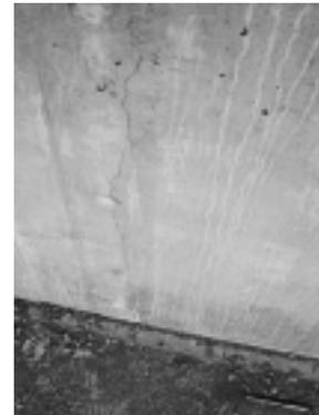
写真-1 底版付根から観察されているひび割れ
