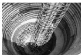
写真-5 配筋完了
