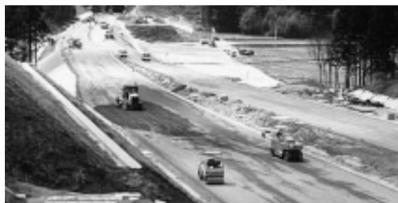
写真-2 上層路盤施工状況
