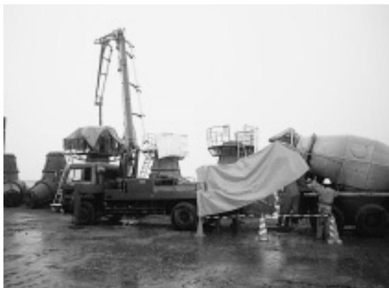
写真-6 降雨時コンクリート打設状況
