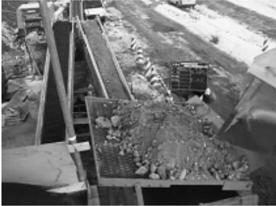
写真-3 現地発生砂の混合
