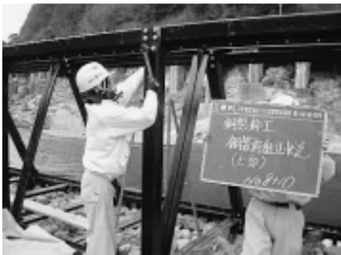
写真-3 鋼製枠組立
