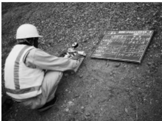
写真-7 施工後試験片付着強度試験
