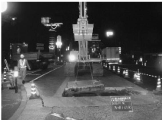
写真-2 舗装版撤去状況
