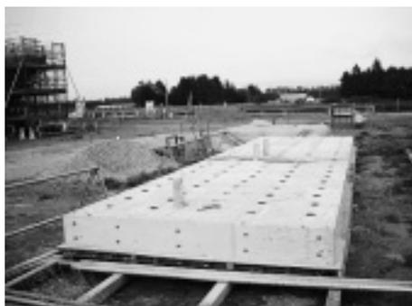
写真-5 試験施工型枠脱型後
