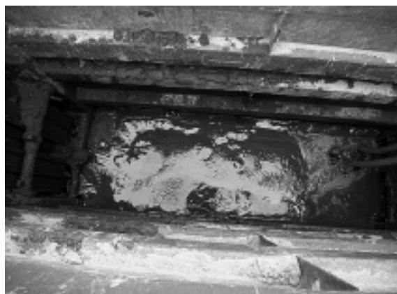
写真-1 現地での掘削によるポイリング状況
