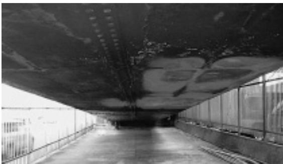
写真-1 被災損傷状況（下フランジ）
