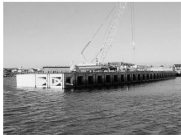
写真-5 面コンクリート完了
