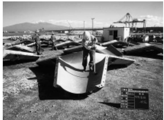
写真-1 型枠清掃状況
