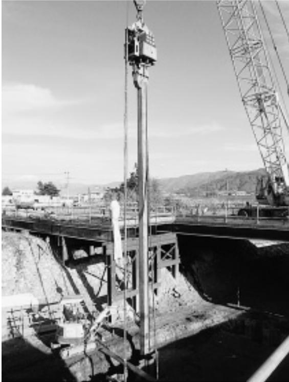
写真-1 鋼矢板打込み (L=22.5m)
