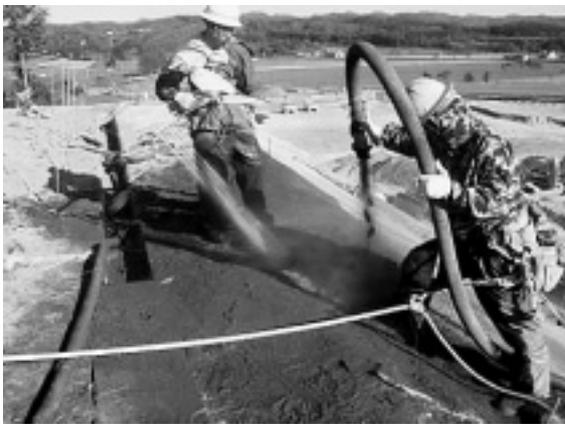
写真-4 連続繊維補強土工施工
