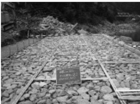
写真-5 鋼製フトン籠設置
