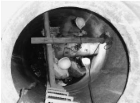
写真-2 人孔内簡易吊具設置
