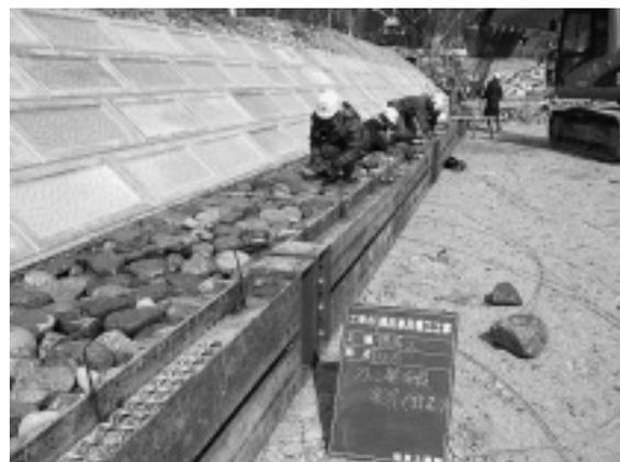
写真-1 H鋼を使用しての詰石作業状況
