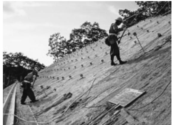
写真-2 アンカー鉄筋挿入
