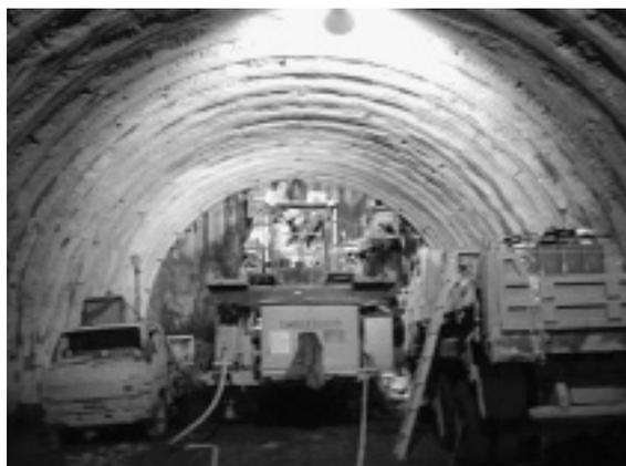
写真-2 AGF 坑内施工
