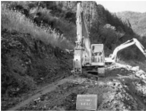
写真-2 コンクリート取壊し
