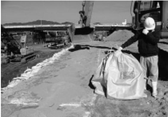
写真-2 セメント系改良材による地盤改良
