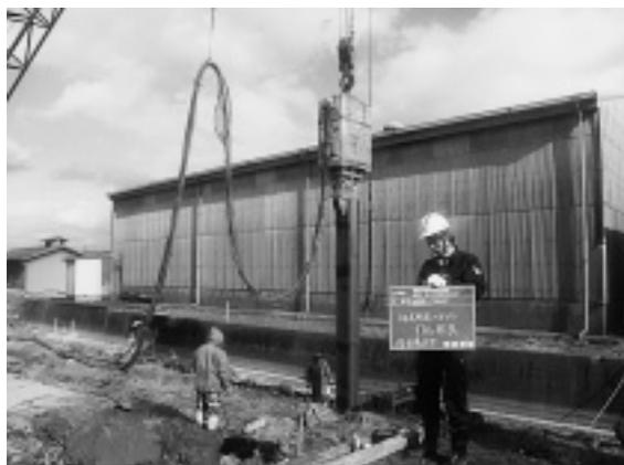
写真-4 試験施工 (超高周波バイブロハンマ)
