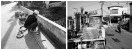
写真-12 カッター切断時の吸収機の使用と汚泥処理機の使用
