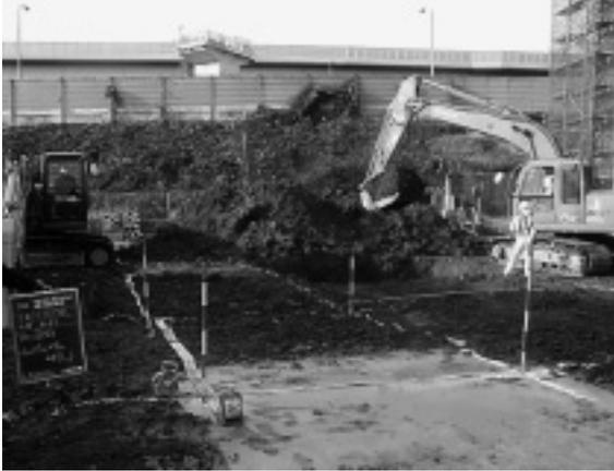
写真-2 攪拌機混合工法施工状況
