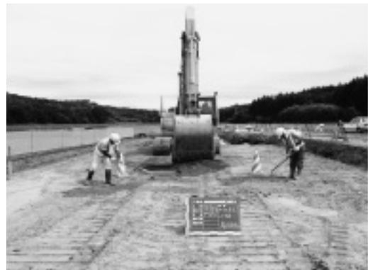
写真-9 サンドマット施工状況
