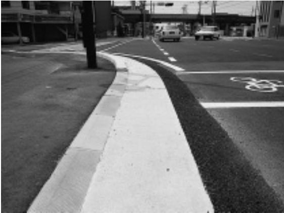
写真-2 現場打ちL型側溝
