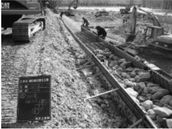
写真-2 H鋼の設置状況
