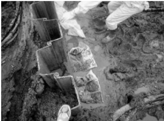
写真-3 セルマット吸着確認
