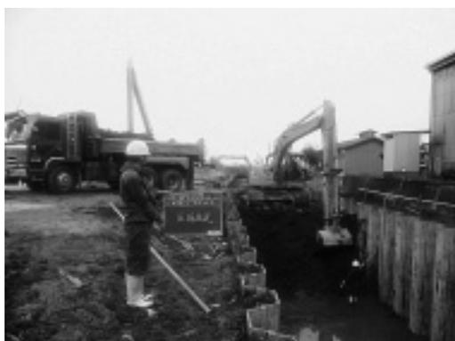
写真-6 矢板水路内による掘削状況
