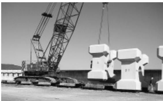
写真-2 吊上げ作業時状況
