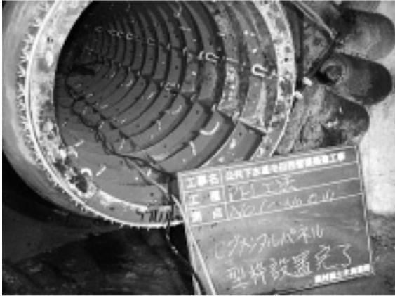
写真-4 セグメントパネル組立工
