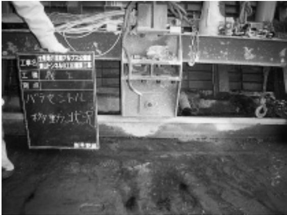
写真-5 バラセントル車輪設置状況
