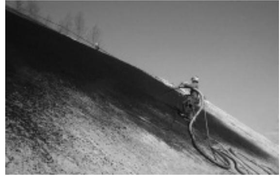
写真-9 吹付け施工状況
