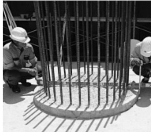
写真-3 杭径の測定
