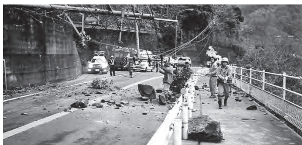
写真1 落石によって被災した国道（筆者撮影）
