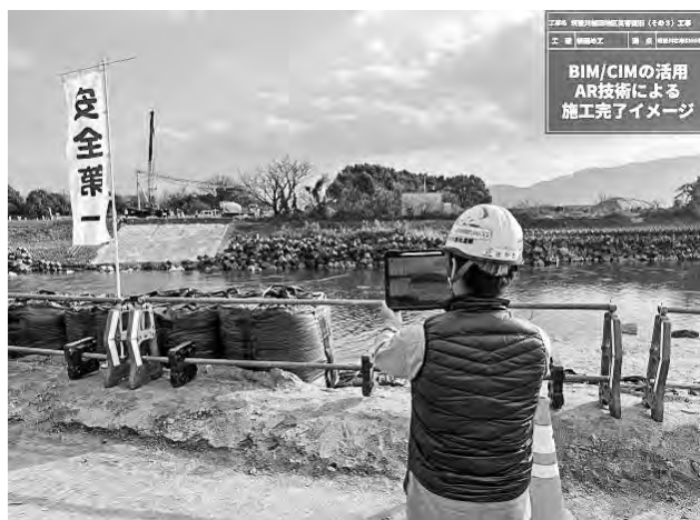
図-2 ARによる視覚化（現地確認）
