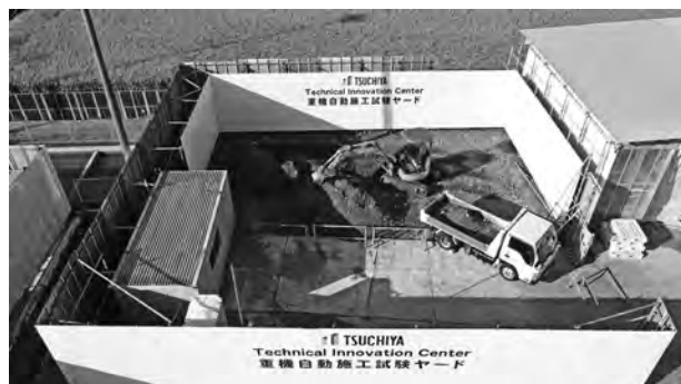
重機自動施工試験ヤード②
