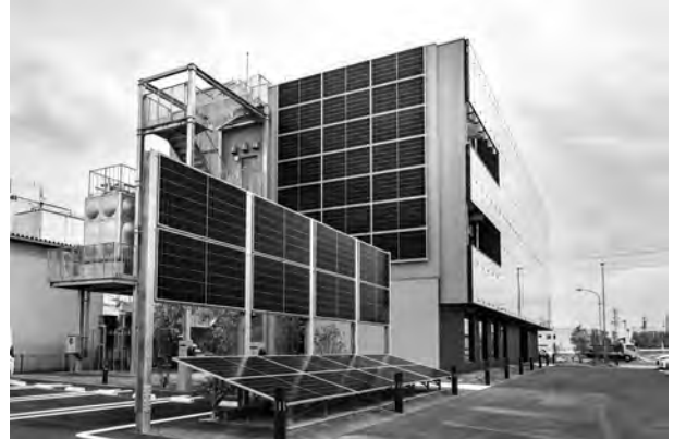
自立式・壁面施工太陽光パネル
