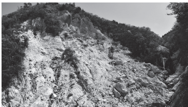
写真2 上部の硬質岩盤から大きな岩塊が崩壊
