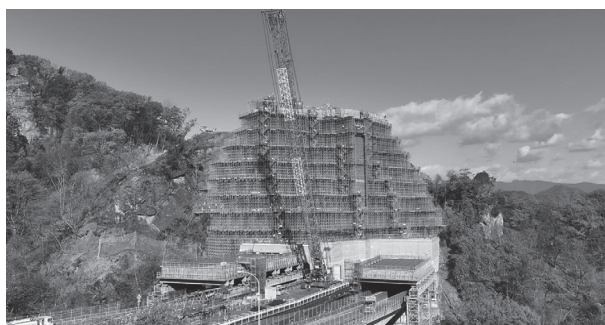
写真3 北野牧トンネルの岩塊除去工事 2)
