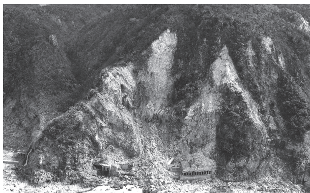
写真1 能登半島地震の岩盤崩壊と被災した旧道
